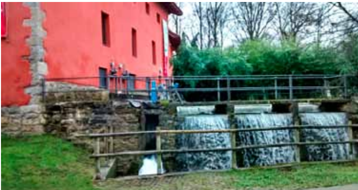
Canal del complejo hidráulico del Molino de San Andrés. Fuente: mcp.es
