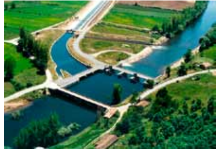
Derivación en canal de riego para aprovechamiento hidroeléctrico en la provincia de León. Fuente: chduero.es
